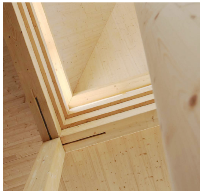
Figure 2 Evangelical Church in Regensburg (D)
