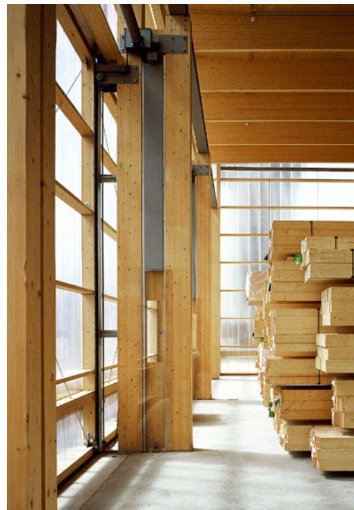
Abb. 6.2 Unmittelbar in Stahlbetonfundamente eingespannte Hallen- und Kranbahnstützen aus BS-Holz
