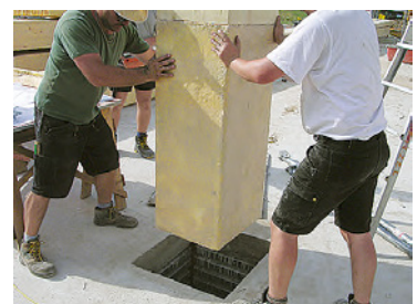
Abb. 6.3 Einbau einer unmittelbar in Stahlbetonfundamente eingespannten BS-Holz-Stütze
