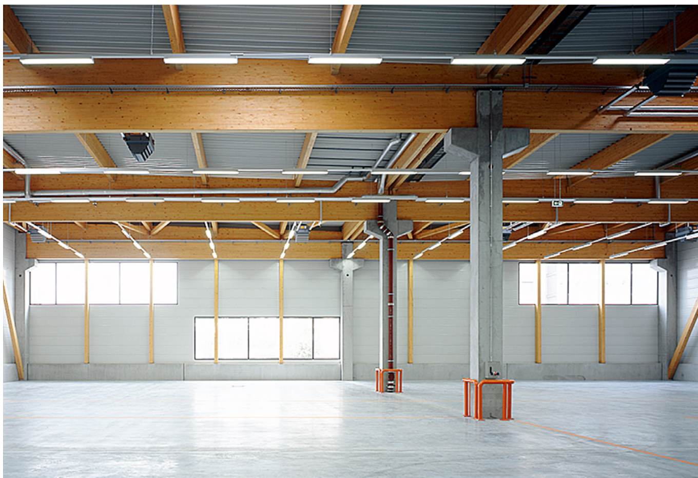
Abb. 1.3 Logistikzentrum mit Haupt- und Nebenträgern aus BS-Holz
